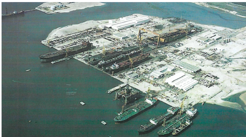
20. Vista aérea dos estaleiros de construção naval da Setenave, na Mitrena-Setúbal, na sequência da decisão de criar um polo de desenvolvimento industrial em 1971.
