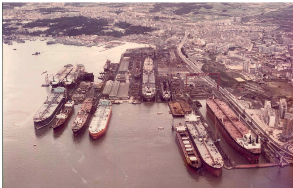
19. Vista panorâmica dos estaleiros de reparação naval da Lisnave, na Margueira-Almada, com destaque para a doca n.º 13, ao tempo a maior doca seca do mundo, batizada em junho de 1971 com o nome Alfredo da Silva, aquando do centenário do seu nascimento.
