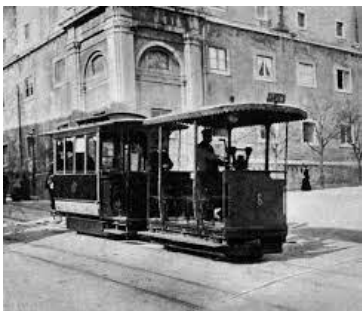
Elétricos de Lisboa
